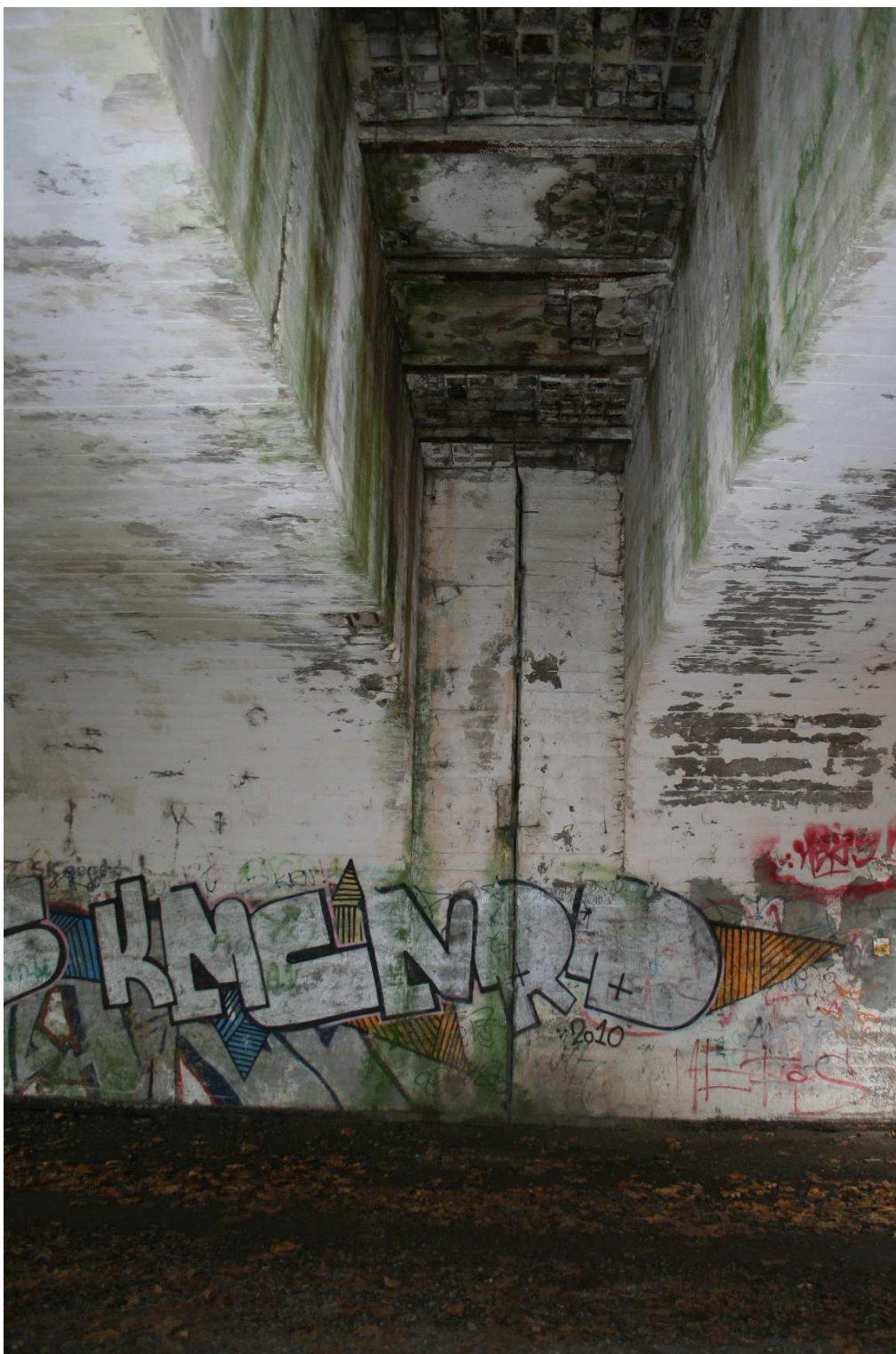
Widok od spodu na połączenie wiaduktów kolejowych (z nawierzchnią kolejową i z rozebraną nawierzchnią)
