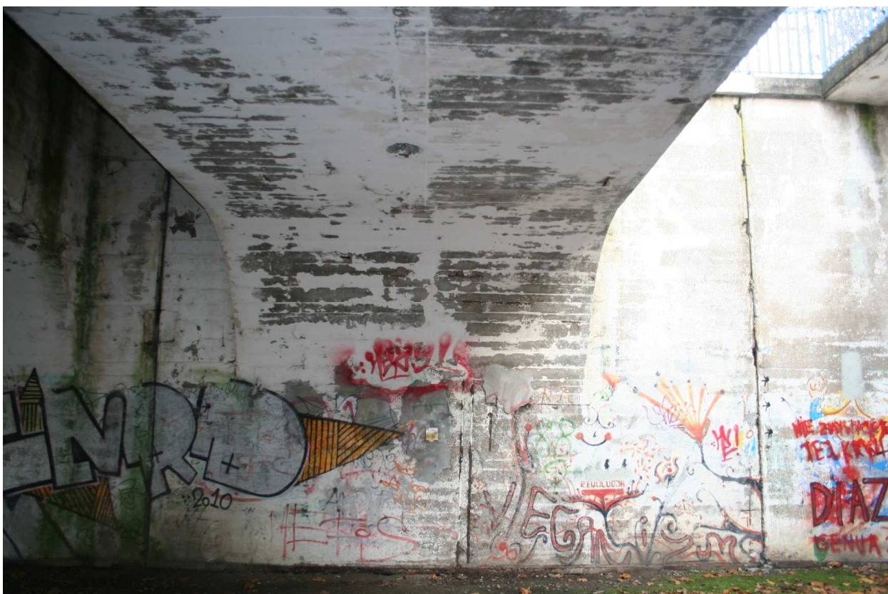
Widok od dołu na wiadukt kolejowy z rozebraną nawierzchnią kolejową
