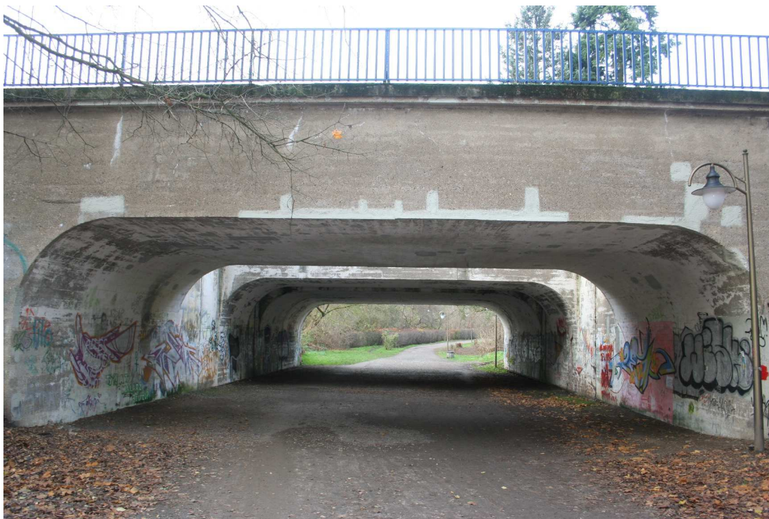
Widok na wiadukt drogowy
