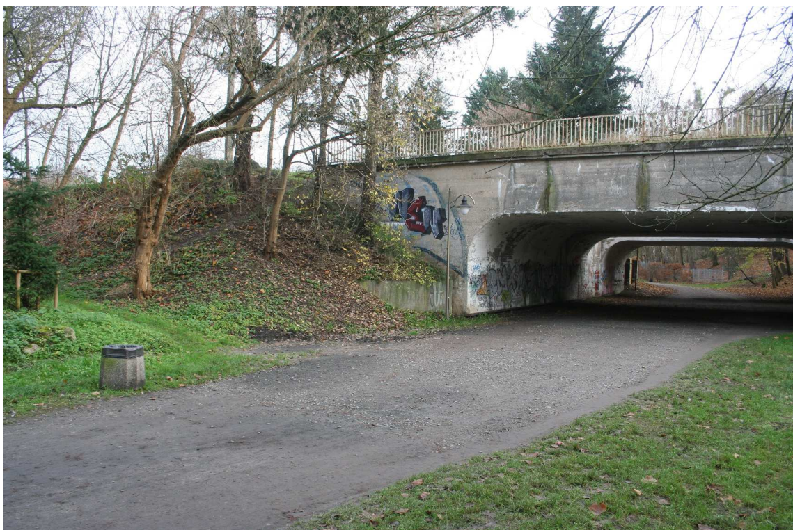
Widok na wiadukt kolejowy
